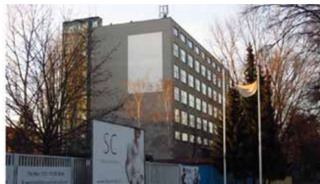
Obr. V pronajatých 1,5 patrech výškové budovy M6 sídlila Teco a.s. 25 let od roku 1993 do konce 2017. Počet zaměstnanců se dlouhodobě ustálil kolem 85.
