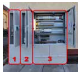
Obr. Koncept bezdrátové komunikace zapínacího místa veřejného osvětlení na nadřazený dispečink, komunikace se servisním personálem a komunikace s každým podřízeným světelným bodem. Komunikační a řídicí centrálou je tu nový Foxtrot 2 a přes jeho síť v pásmu 868 MHz lze připojovat i další senzory a přirozeně tak rozšiřovat internet věcí (IoT).
