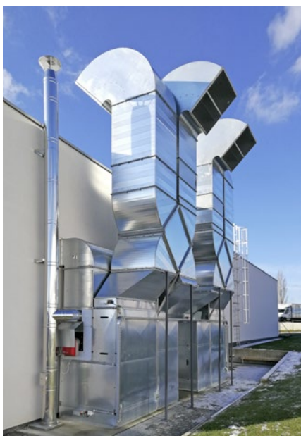
Obr. Metače tepla Argus a vzduchotechnika od CIC Hřebec, které Foxtrot poveluje, jsou dalšími technologiemi, které ovlivňují vnitřní klima budovy.
