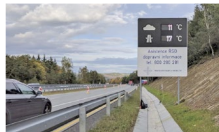
Obr. Foxtroty odvádějí svoji nepřetržitou práci také v informační tabuli o teplotě vzduchu 1 a povrchu dálnice na jejím šestém úseku a také na dvou výstražných proměnných dopravních značkách (PDZ) s informací o meteo situaci. Foto: Vít Jadrníček
