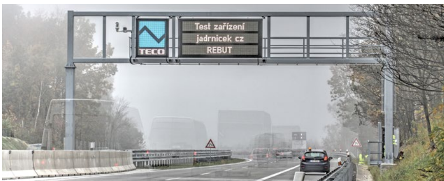
Obr. Na třech portálech, postupně na 33,6 km, na 54,4 km a na 55,2 km dálnice D1 pracují nad hlavami řidičů Tecomaty Foxtroty ve funkci komunikační jednotky, které pro portál zpracovávají povely z Národní dopravní informační centrály. Foto: Vít Jadrníček
