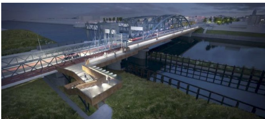
Obr. Součástí řízené soustavy je i osvětlení schodiště z mostu na břeh řeky.
