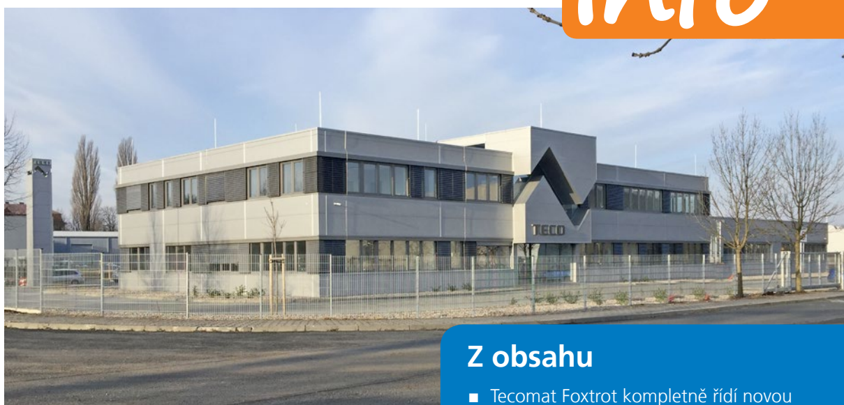
Nová budova Teco a. s., je postavena v průmyslové zóně na východním okraji Kolína.
