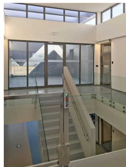
Obr. Komunikačním centrem budovy, které je prosklené a prosvětlené ze všech stran, vede schodiště i zvedací plošina do patra, kde na ně navazují dvě venkovní terasy skryté za logem na fasádě.
