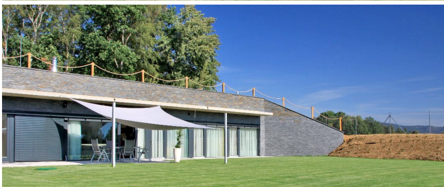
Obr. Realizované domy společnosti KONHEFR mají pro automatizované řízení infrastruktury instalovaný Tecomat Foxtrot.
