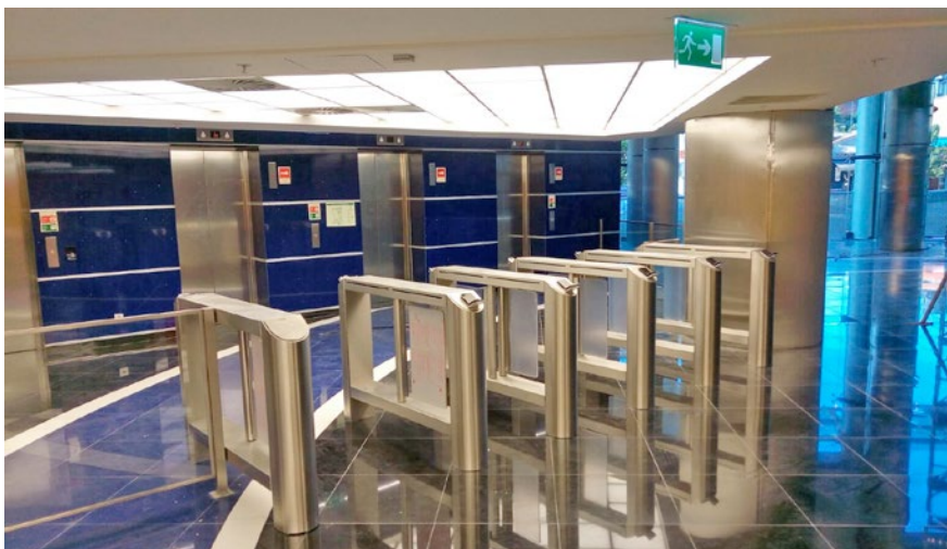
Obr. Vstupní turnikety tvoří základ přístupového systému v bance.
