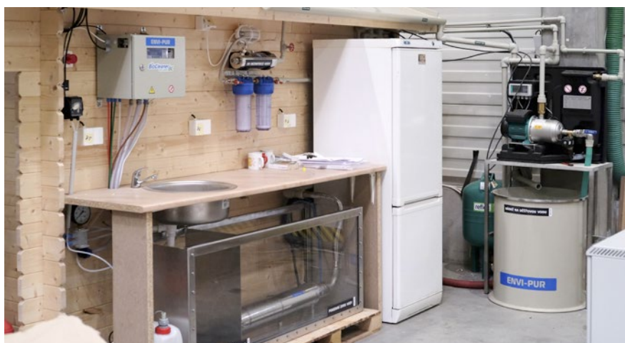
Obr. Testovací sestava ve skladové hale. Vnitřní rozměry zahradního domku mají identické rozměry jako budoucí technická místnost. Vybavení ostrovního domu – chladnička, úprava vody, příprava teplé, odpady včetně čističky jsou tu umístěny vně.
