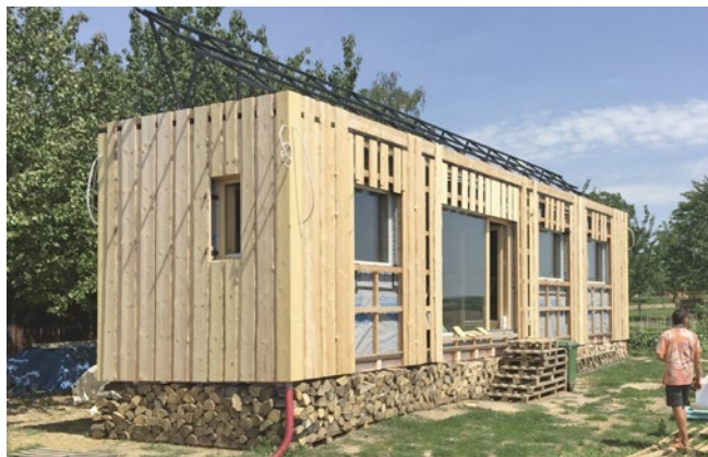
Obr. Jeho autor Daniel Brýda ho nakonec realizuje svépomocí doma na Jižní Moravě s výhledem na Slavkovské bojiště (stav uprostřed prací v létě 2017). Až ho dostaví a zareguluje Foxtrot, bude si moci pozemek pod něj vybrat kdykoliv později. Může ho opravdu naložit na truck a odjet hledat další výhledy.
