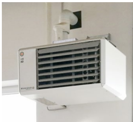
Obr. Metače tepla Argus a vzduchotechnika od CIC Hřebec, které Foxtrot poveluje, jsou dalšími technologiemi, které ovlivňují vnitřní klima budovy.
