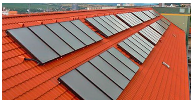
60m 2 panelů SunTime na bytovém domě v Mostě.
