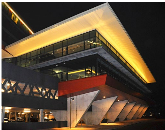
Pavilon s restaurací a kongresovými sály v horním patře
