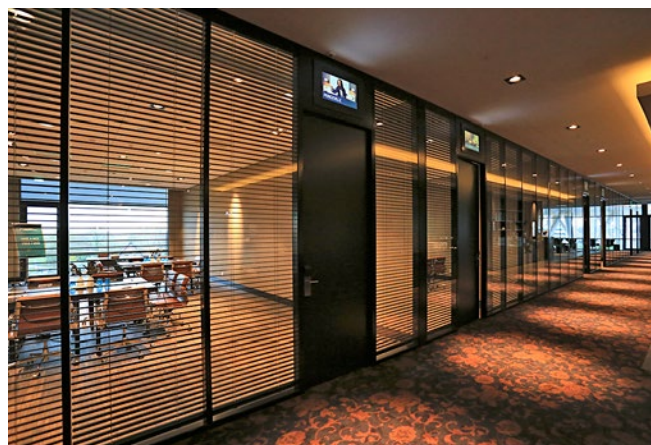
Šest samostatných salónků v řadě má směrem do chodby skleněné stěny s vestavěnými žaluziemi. Jsou ovladatelné individuálně z řídicího pultu v každé místnosti.
