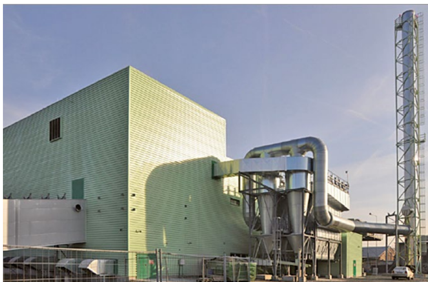
V BIOENERGO KOMPLEX v Kolině je Foxtrot nasazen na řízení spalování biomasy v kotli pro 6MW generátor
