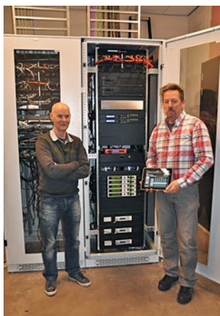
Herman a Arjan. Specialisté firmy B&R Design dodali kompletní rozvaděč s AV technikou a řídicím systémem Foxtrot (3 ks v dolní části rozvaděče), který řídí patro hotelu s patnácti kongresovými sály.
