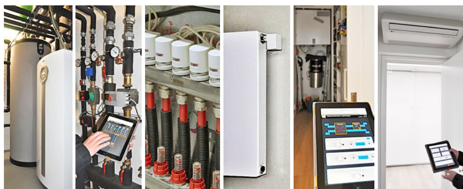
Klima v domě a v každé jeho místnosti řídí Foxtrot. Od tepelného čerpadla přes jednotlivé topné větve, podlahové vytápění, radiátory, ventilaci s rekuperací a klimatizační jednotky v každé místnosti. Vše přehledně vizualizováno na tabletu.
