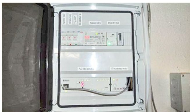
Instalace Foxtrotu v rozvaděči v Policejní škole v Praze.
