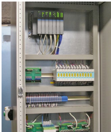
Obr. Systém sběru dat z modernizovaného olejového hospodářství byl svěřen Tecomatu TC700
