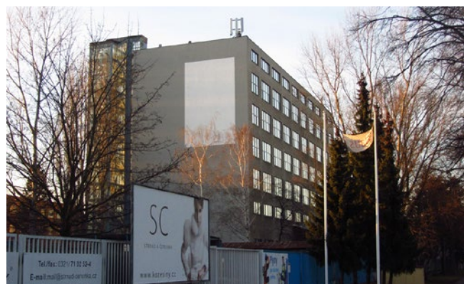
Obr. V pronajatých 1,5 patrech výškové budovy M6 sídlila Teco a.s. 25 let od roku 1993 do konce 2017. Počet zaměstnanců se dlouhodobě ustálil kolem 85.
