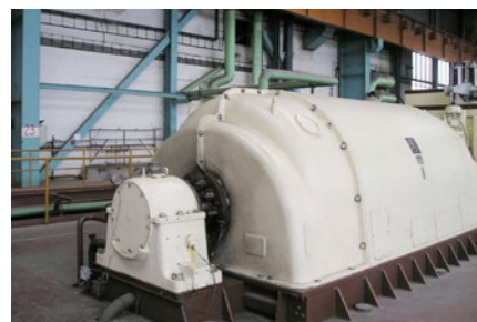
Obr. Parní turbína v Martinské teplárenské je řízena systémem Tecomat NS950
