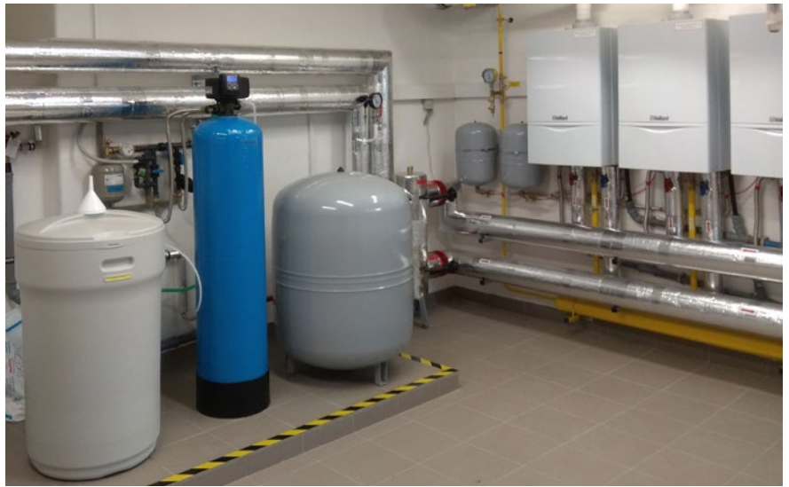
Obr. Centrální zdroj tepla s kaskádou plynových kotlů
