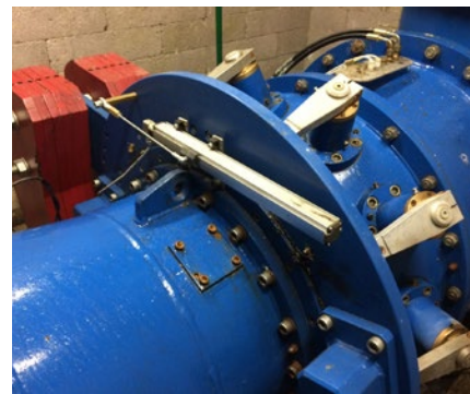
Obr. Řízení rozvodného kola Kaplanovy turbíny. Tecomat Foxtrot adaptivně nastavuje jak rozvodné tak oběžné kolo pro maximalizaci výstupního výkonu na generátoru.
