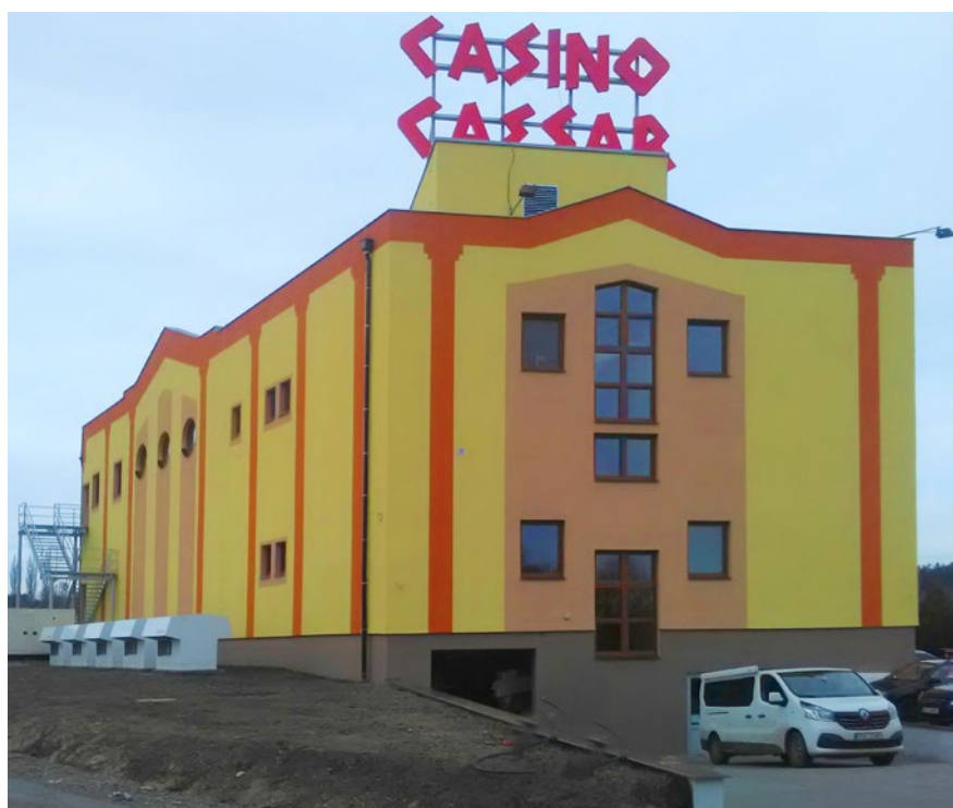
Obr. CASINO CAESAR– vlevo kaskáda pěti tepelných čerpadel vzduch-voda 5x WPL57
