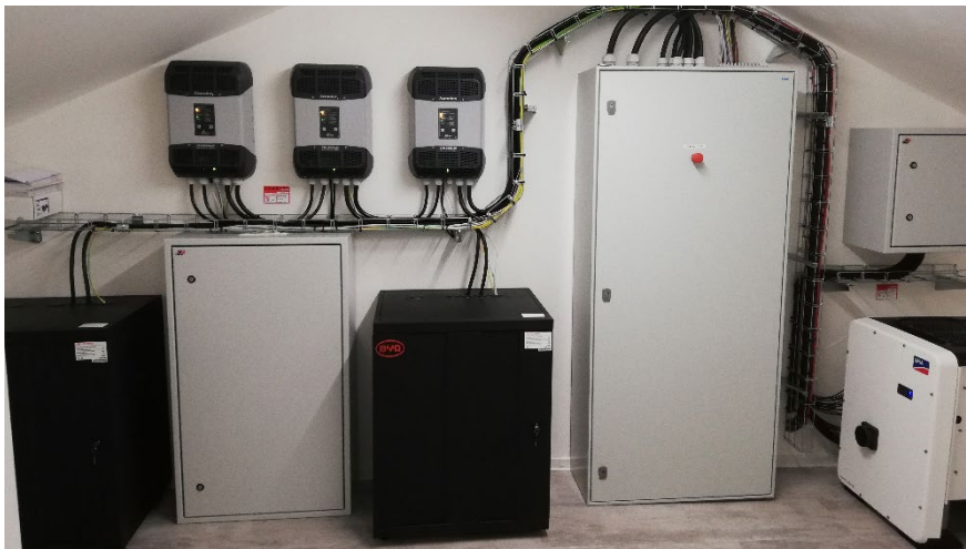
Obr. Instalace 3 fázové hybridní elektrárny v Jimi Tore s.r.o.
