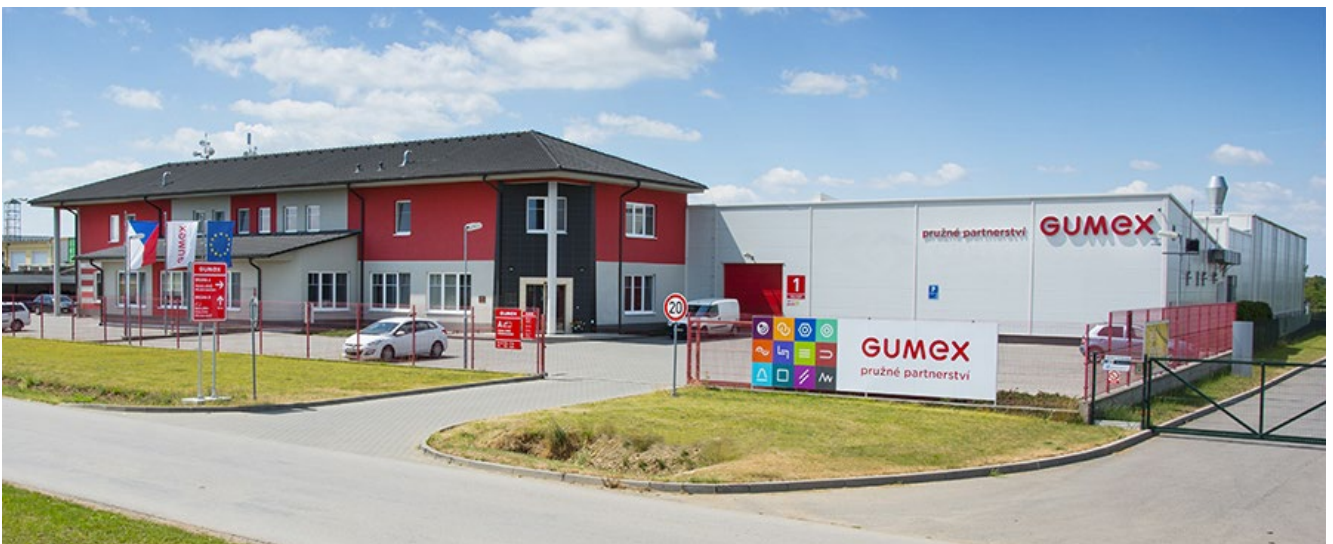
Obr. Ve firmě GUMEX realizovala firma Hora Energy hybridní FVE s bateriovým uložením řízenou Foxtrotem v roce 2018
