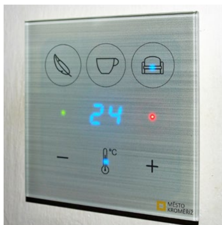
Obr. Dotykový ovladač na stěnu řady Touch@Glass připojovaný sběrnici CIB.
