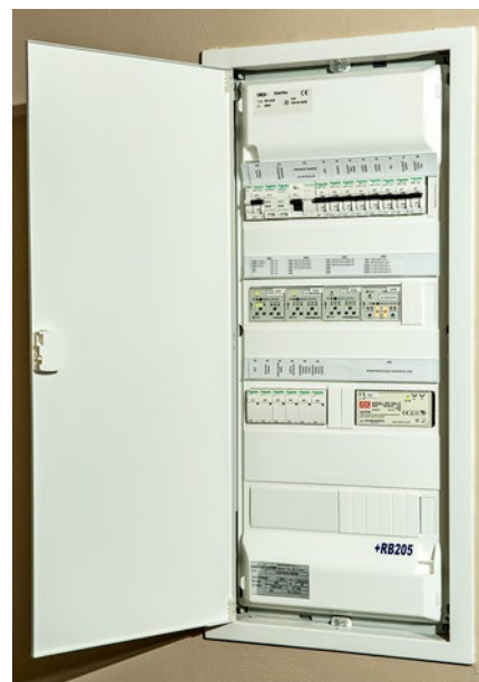
Obr. Každý pokoj má ve svém rozvaděči ovládací moduly CFox připojené k centrálnímu Foxtrotu sběrnici CIB.
