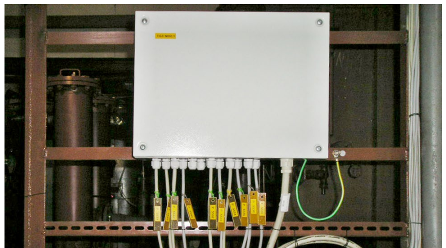
Obr. Systém sběru dat z modernizovaného olejového hospodářství byl svěřen Tecomatu TC700
