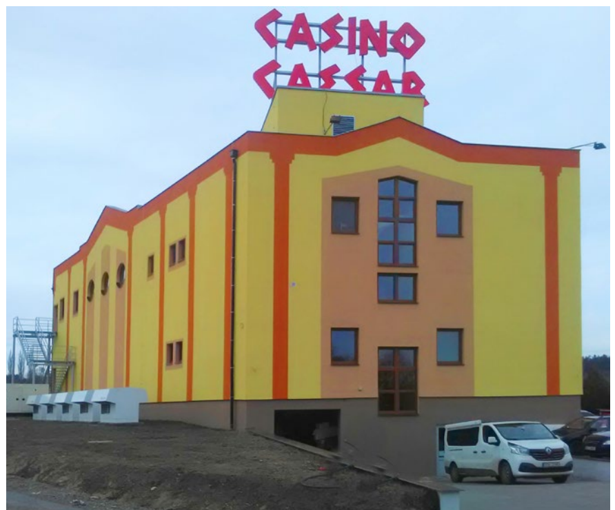
Obr. CASINO CAESAR– vlevo kaskáda pěti tepelných čerpadel vzduch-voda 5x WPL57
