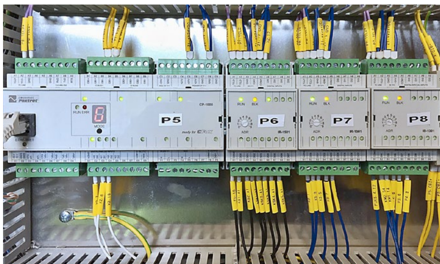
Obr. Základní modul a 3 rozšiřující moduly obsáhnou řízení celé MVE
