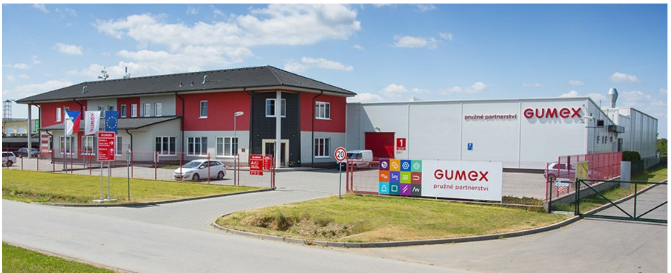
Obr. Ve firmě GUMEX realizovala firma Hora Energy hybridní FVE s bateriovým uložštěm řízenou Foxtrotem v roce 2018
