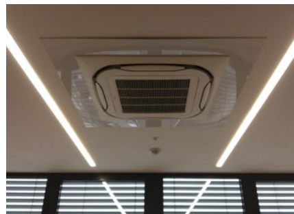
Obr. 4. Žaluzie, svítidla, chlazení, topení, větrání i přístupový systém tu pod taktovkou Foxtrotu tvoří integrovaný a logicky fungující celek v každé kanceláři
