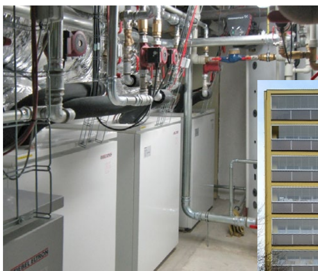
Obr. Bytový dům na Francouzské v Kopřivnici má nasazenu kaskádu čtyř tepelných čerpadel Stiebel Eltron vzduch-voda typu WPL23E. Již 7 let tu prokazatelně uspoří minimálně 50% nákladů proti klasickému CZT (Centrální zásobování teplem).
