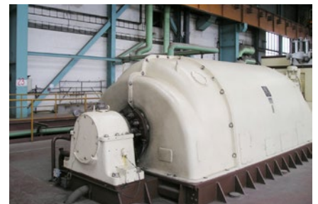
Obr. Parní turbína v Martinské teplárenské je řízena systémem Tecomat NS950
