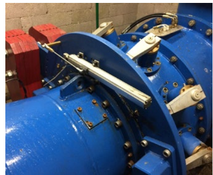
Obr. Řízení rozvodného kola Kaplanovy turbíny. Tecomat Foxtrot adaptivně nastavuje jak rozvodné tak oběžné kolo pro maximalizaci výstupního výkonu na generátoru.
