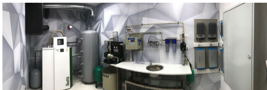
Obr. Unikátní showroom Foxtrotem řízené technologie ostrovního domu, tedy nepřipojeného k elektrické síti, je ke shlédnutí v Praze u firmy ELPRAMO.
