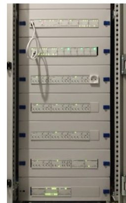
Obr. 8. Řídicí systém Foxtrot pro celé patro v centrálním rozváděči; zde jsou instalovány převodníky pro šest větví sběrnice DALI; další prvky instalované přímo v místnostech jako čidla a vypínače jsou připojeny prostřednictvím sběrnice CIB (Common Installation Bus ® )
