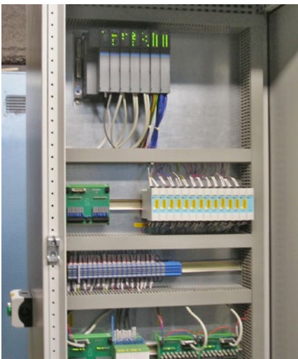
Obr. Systém sběru dat z modernizovaného olejového hospodářství byl svěřen Tecomatu TC700
