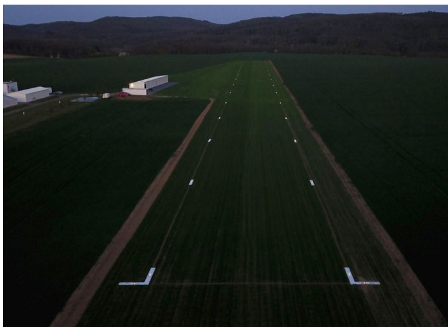
Osvětlení přistávací dráhy pro sportovní letadla si pilot zapne dálkově podle své potřeby. Svým mobilním telefonem. Pokyn přijme a vykoná Foxtrot instalovaný v novém hangáru.
