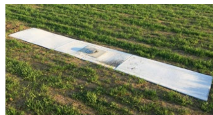
Detail světla na přistávací dráze umístěného v centru bílé plochy s vysoce odrazivým povrchem.
