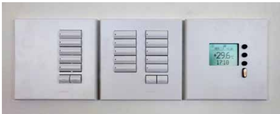
Obr. 3 Integraci Tecomatu Foxtrot pro vytápění a kombinace instalace KNX s instalací Lutron provedly firmy KD Elektronika a Elpramo v Berlíně
