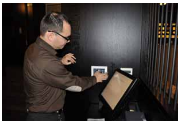
Obr. 3. Ovládací panely osvětlení jsou v dosahu obsluhy stejně jako ovládání klimatizace, hned vedle restaurační pokladny
