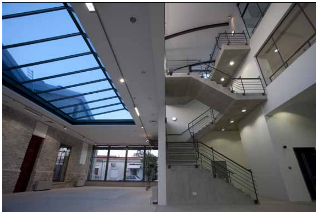
Obr. 4. Střízlivé propojení zrekonstruovaných hal staré tiskárny a nové budovy muzea; velké prosklené plochy dávají nahlédnout hluboko dovnitř a řízený systém osvětlení dává vyniknout starým i novým konstrukcím muzea zejména za šera a v noci
