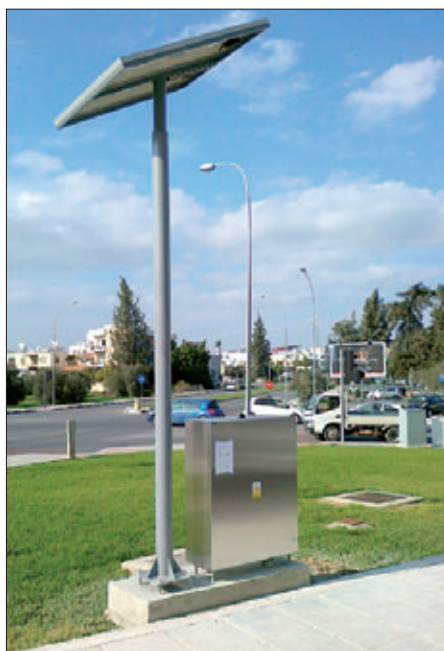
Obr. 6 Foxtrot jako telemetrie na vodárenské síti v Nicosii a Larnace na Kypru
